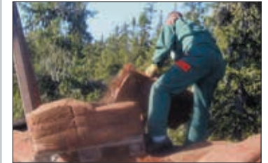
Fordeling av torvsekker på taket
