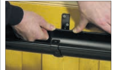
Montering av takrenne
