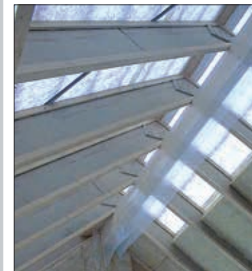
Dampsperre trukket over mønesåsen
