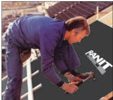
Montering av forenklet damptett undertak (sutaksplater)
