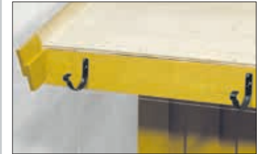
Montering av rennekroker
