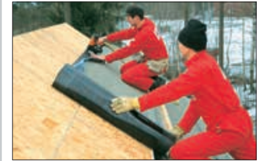
Montering av asfalt underlagsbelegg
