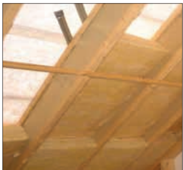
Isolering av sperretak
