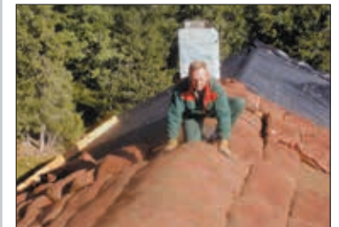
Plassering av torvsekker over mønet
