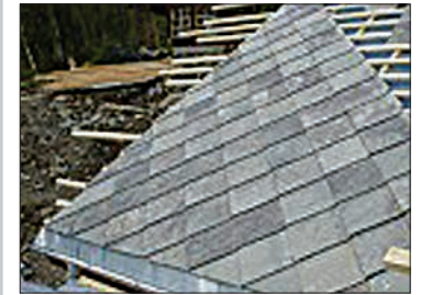
Montering av takskifer Firkant
