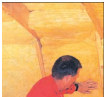
Isolering av A-takstoler
