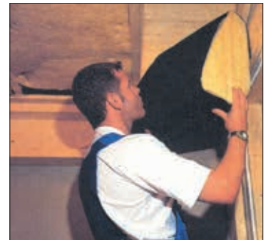
Isolering med rafteplate
