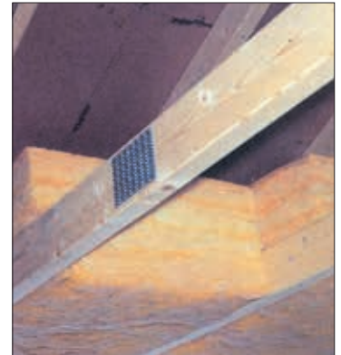
Isolering med takstolplate
