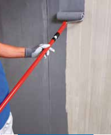
Påføring av Eco Prim Grip på betong med rulle
