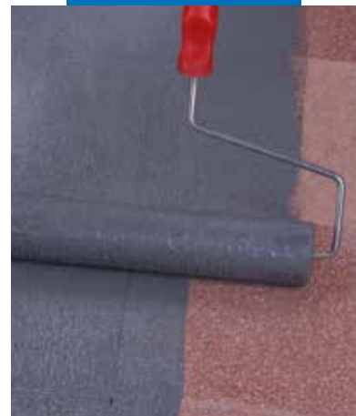
Påføring av Eco Prim Grip med rulle på eksisterende terrazzo gulv
