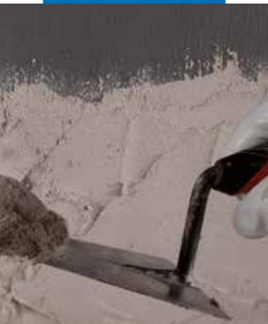
Påføring av puss over Eco Prim Grip
