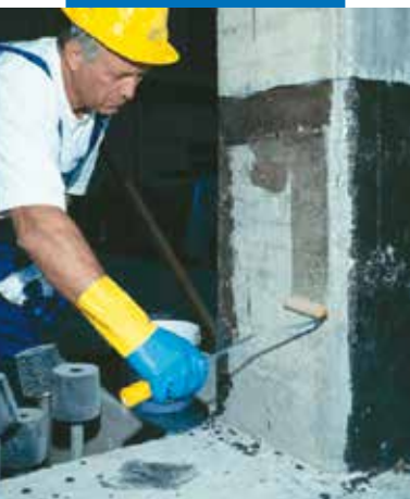
Påføring av første strøk med MapeWrap Primer 1
