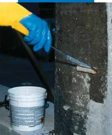
Påføring av andre strøk med MapeWrap Primer 1
