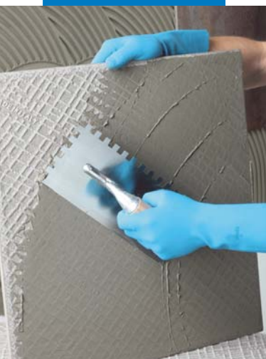
Påføring av lim på baksiden av flisene
