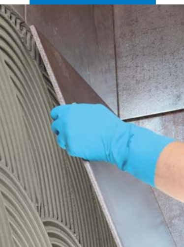
Legging av store fliser på vegger
