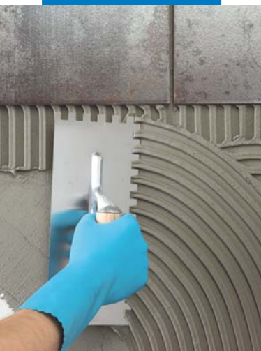
Påføring av Ultralite S1 med en tannsparkel
