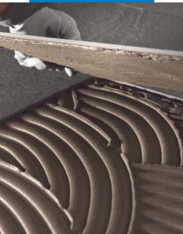
Montering av tynne porselenatfliser på gulv
