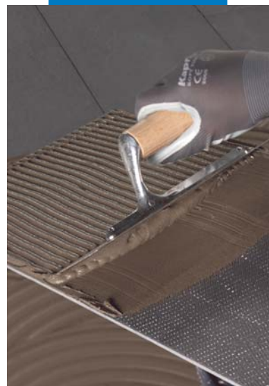
Påføring av lim på baksiden av flisene
