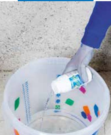
Tilsette Mapetard ES til blandedvannet for Planitop Smooth & Repair R4 eller Planitop Smooth & Repair før blanding
