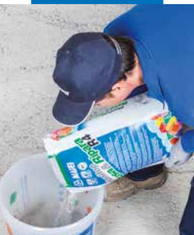
Tilsette Planitop Smooth & Repair R4 eller Planitop Smooth & Repair i blandedvannet blandet med Mapetard ES
