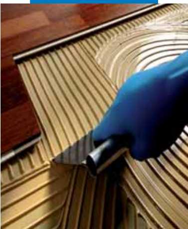
Liming av parkett med Ultrabond Eco S955 1K
