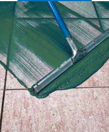
Fuging av gulvfliser med nal
