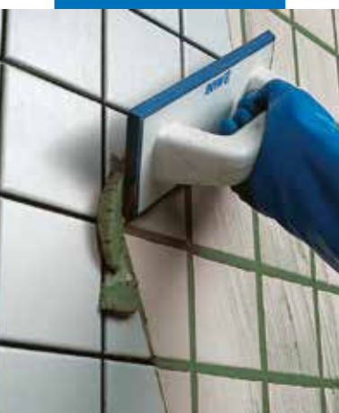
Fuging av vegg med gummibrett
