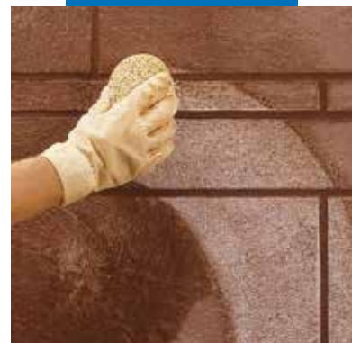
Vasking og sluttbehandling av fuger med svamp
