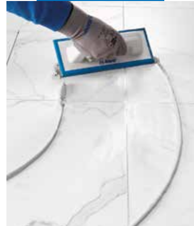
Fuging med Ultracolor Plus på marmorfliser med gummibrett
