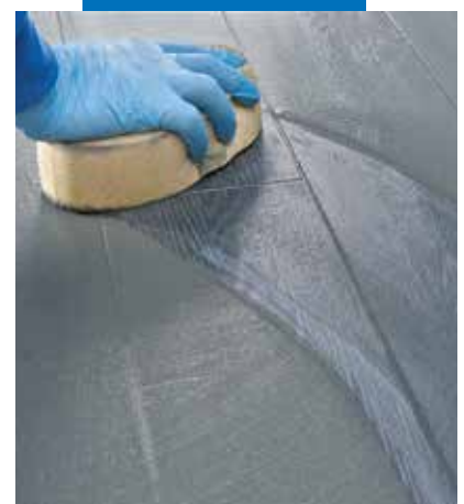
Vasking og sluttbearbeiding av fuger med hard cellulose svamp
