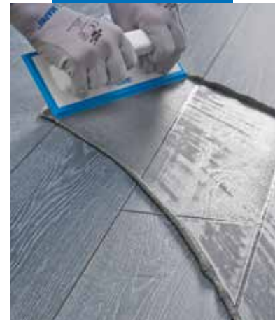
Fuging av Ultracolor Plus med gummibrett på porselen fliser med tre-struktur
