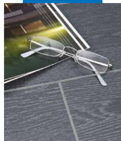
Porselensfliser med tre-struktur fuget med Ultracolor Plus
