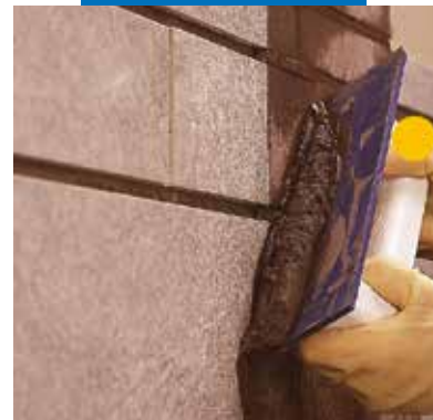
Fuging av vegg med gummibrett
