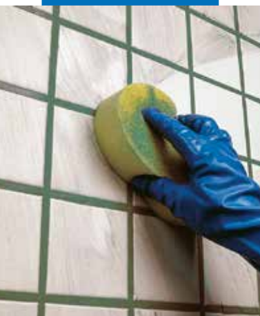
Vasking og sluttbearbeiding av vegg med svamp
