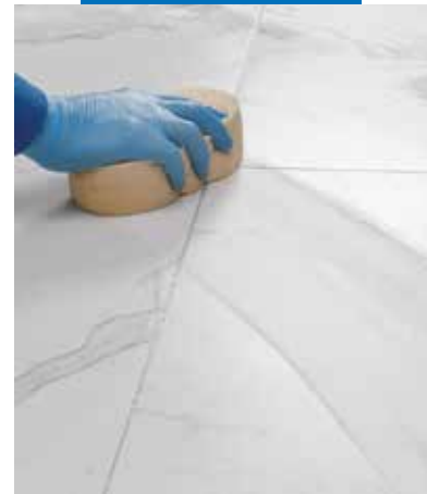
Vasking og sluttbehandling av fuger med hard cellulose svamp
