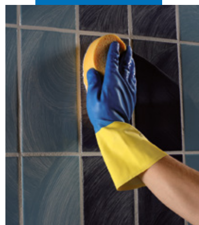
Rengjøring og sluttbehandling med hard cellulose svamp
