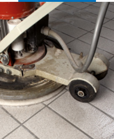
Rengjøring av overflaten med vann og gulvslipemaskin med spesielle filtslipeskiver som f.eks Scotch-Brite®
