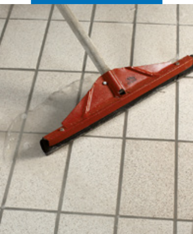
Overskytende vann fjernes med gummisvaber
