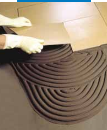
Legging av porselensfliser på et avrettingslag som er blitt impregnert med Mapelastic
