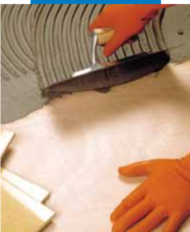
Legging av porselensfliser på et underlag av maritim finer med Elastorapid
