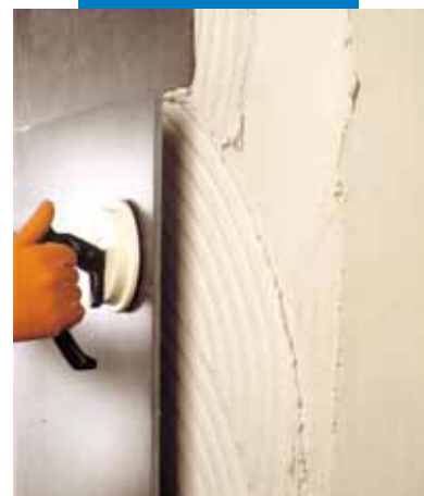
Setting av store porselensfliser på en betongfasade med Elastorapid
