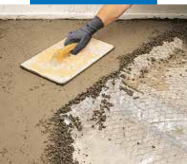
Rør dækkes med Mapecem og armeringsnet
