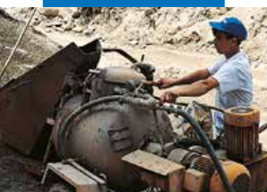
Blanding af Mapecem med en automatisk pumpe
