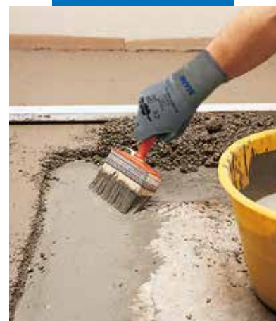
Fordeling af forankringsopslemning til bundne Mapecem afretningslag
