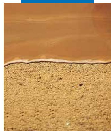
Slutbehandling af Mapecem afretningslaget med selvnivellerende Ultraplan
