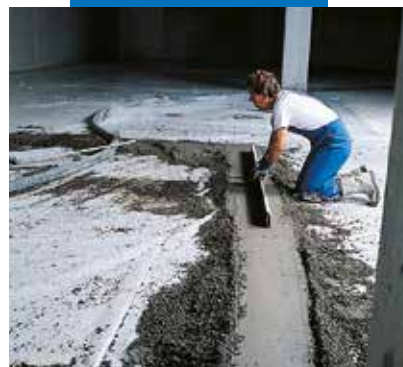
Forberedelse af en nivelleringsliste
