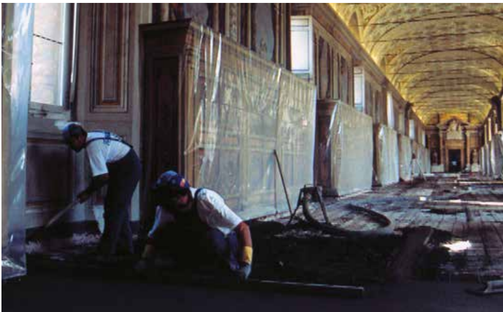
Påføring og udglatning af Mapecem afretningslag – Sistine Halls – Vertikanet
