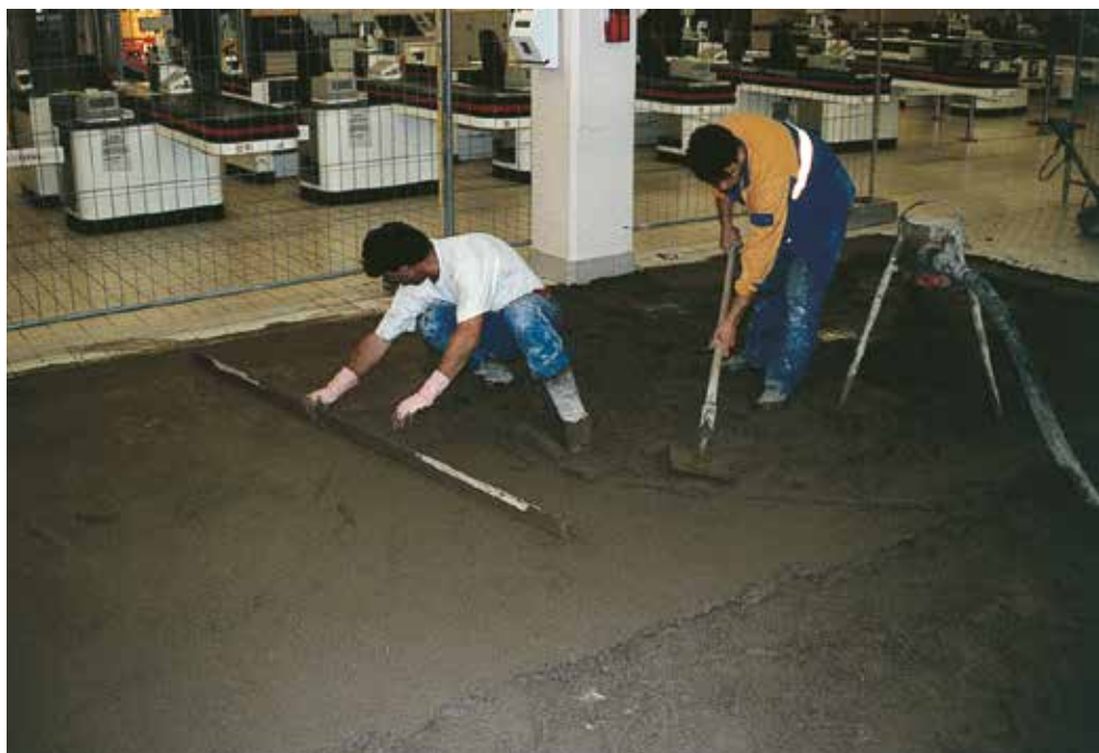
Hurtig reparation af afretningslaget i et supermarked
