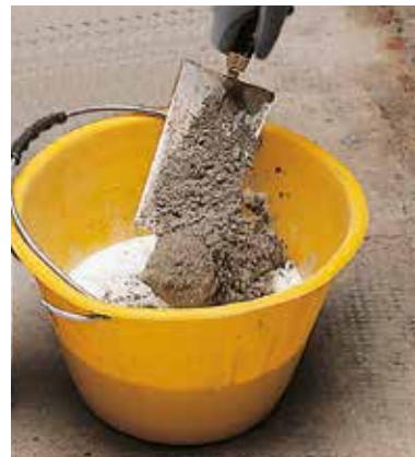
En blanding af Mapecem og Planicrete danner en forankringsopslæmning
