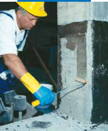
Påføring av et strøk med MapeWrap Primer 1
