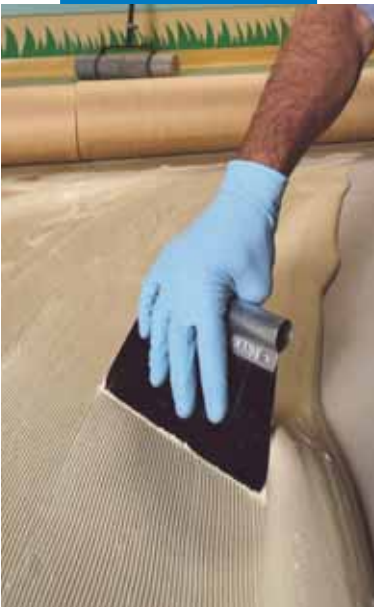
Påføring av Ultrabond Eco 520
