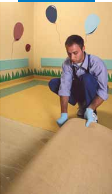
Legging av linoleum med jute bakside
