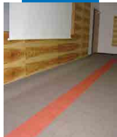
Primer G før utlegging av Ultraplan Eco og Rollcoll lim, brukt for å feste gulvteppe i hotellrom på Villa Hotel Castellani - Østerrike
