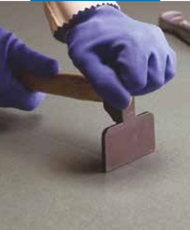
Presse ned skjøter mellom ark
