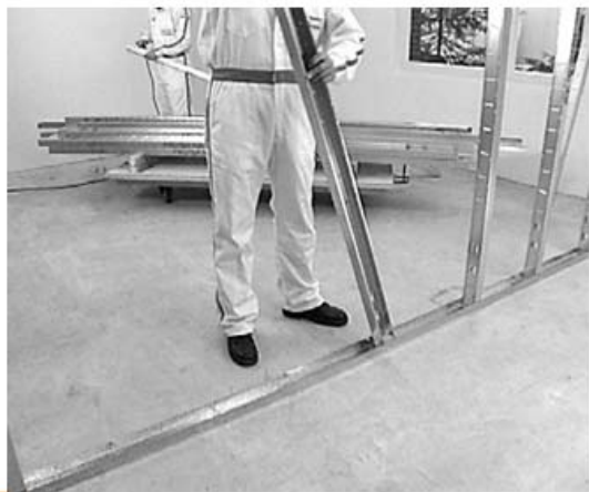
Montering av stålprofiler i topp- og bunnskinne av stål.
