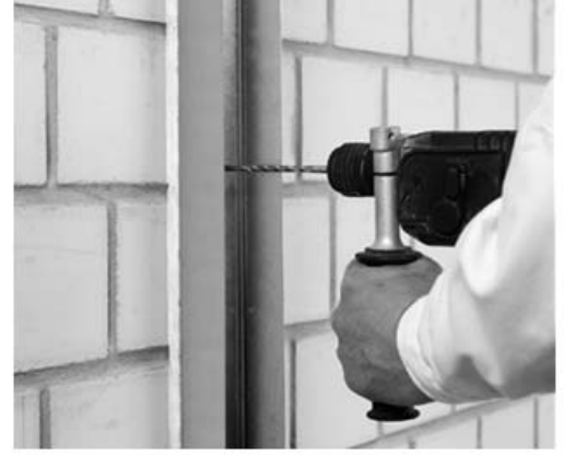
Montering av C-profiler på veggene med en lydisolerende filt- eller mineralullstrimmel.
