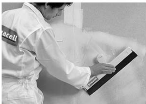
Finsparkel-behandling gir glatte overflater.
