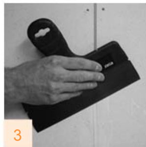
3 Sparkle helt ut med FERMACELL fugesparkel
