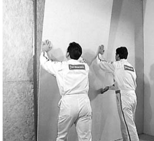
Montering av plater på en underkonstruksjon i tre.
