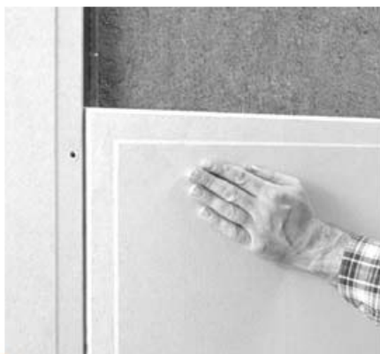
Skjøting av fibergipsplater med sparkelkant.
