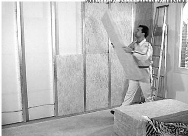
Montering av isoleringsmatter av mineralull.
