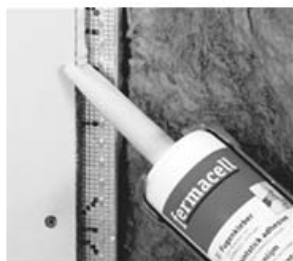
Limfugen påføres i midten på platekanten i en 3 mm limstreng.
