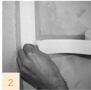
2 Sparkle over med FERMACELL fugesparkel, og legg på FERMACELL papirameringsbånd
