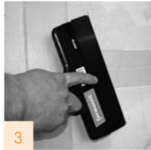
3 Sparkle ut med FERMACELL fugesparkel
