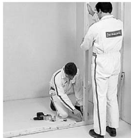
Høyre: Montering av underkonstruksjon i treverk.
