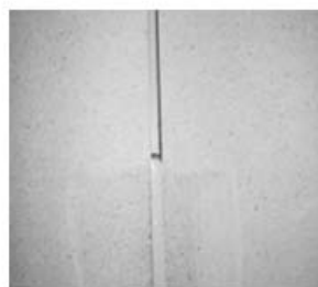
Lag et mellomrom på 5-7 mm ved FERMACELL fugesparkelskjøten.
