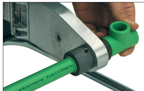
Oppvarming av rør og rørdel
