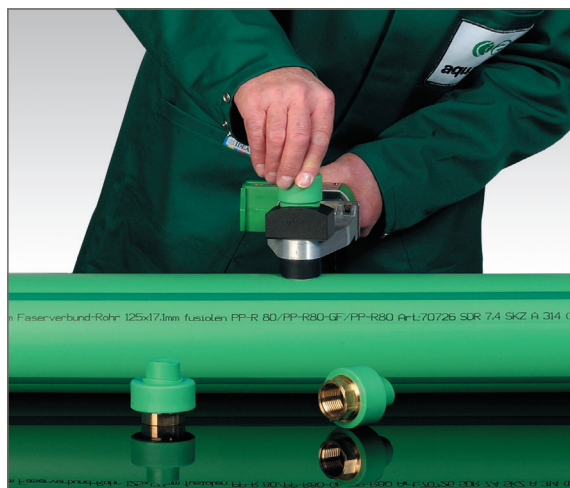
Oppvarming av rør og rørdel
