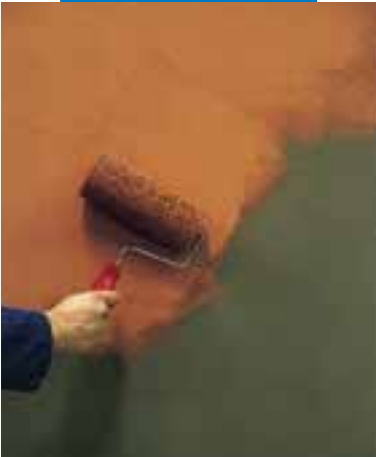
Påføring av Elastocolor Rasante med svamprulle
