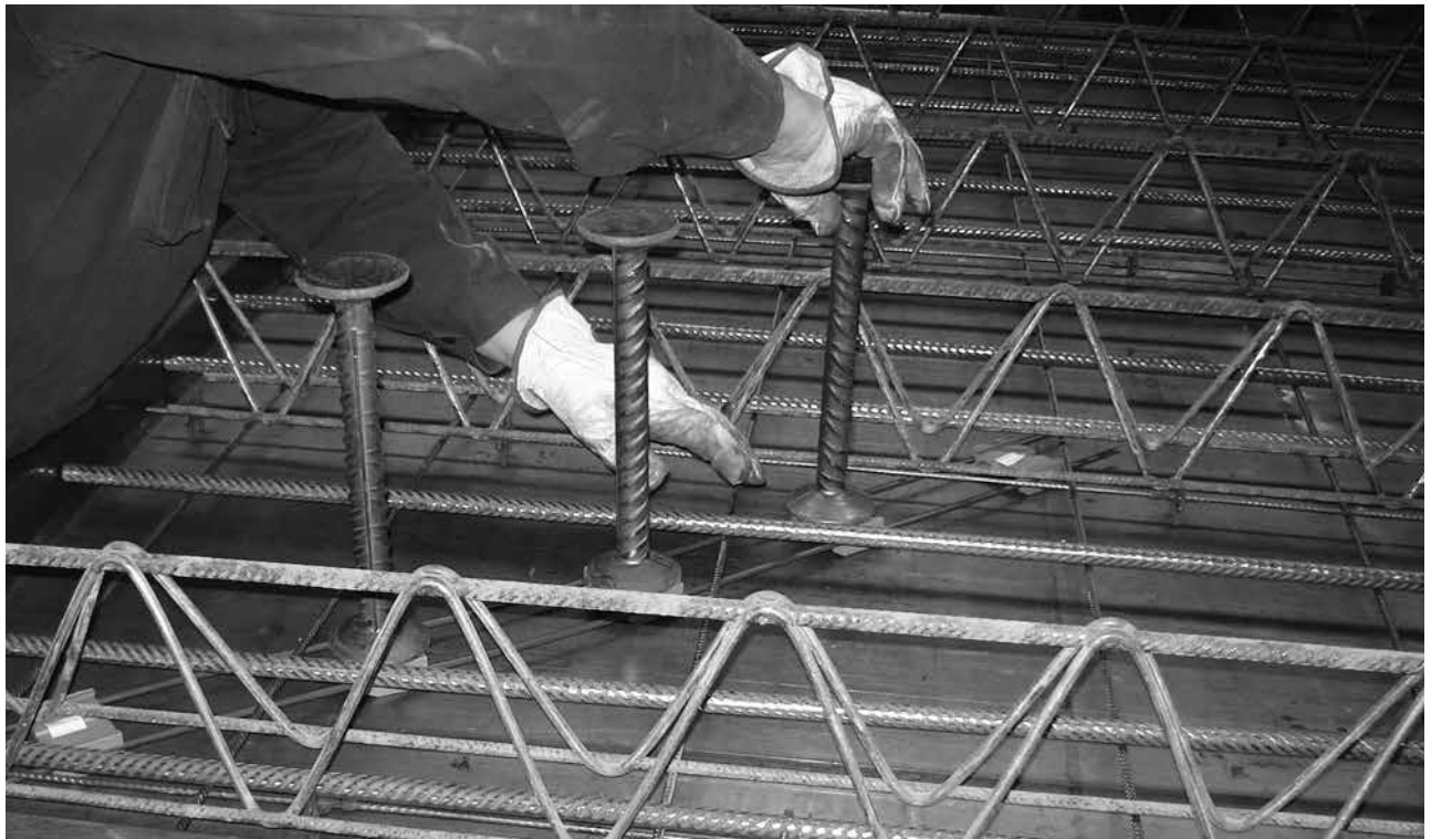
Schöck Bole® Typ F: Eindrehen der Bolzen in Kunststoffleisten nach dem Verlegen der unteren Bewehrung.
