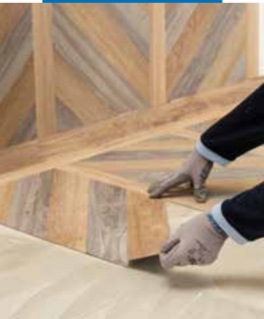
Montering av MODULÆR LVT med Ultrabond Eco V4 Evolution
