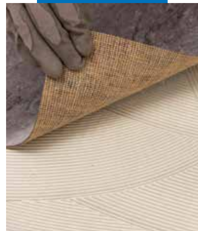
Montering av linoleum med Ultrabond Eco V4 Evolution
