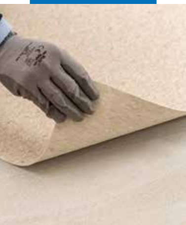
Montering av homogen PVC med Ultrabond Eco V4 Evolution
