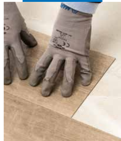
Montering av LVT med Ultrabond Eco V4 Evolution
