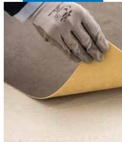
Montering av polyuretanbasert belegg med Ultrabond Eco V4 Evolution
