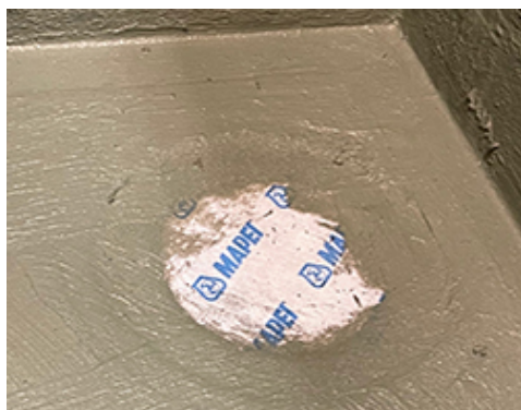
Mapeband B DC montert over sluk og smurt med Mapeguard WP 2K Membrane før klemring monteres
