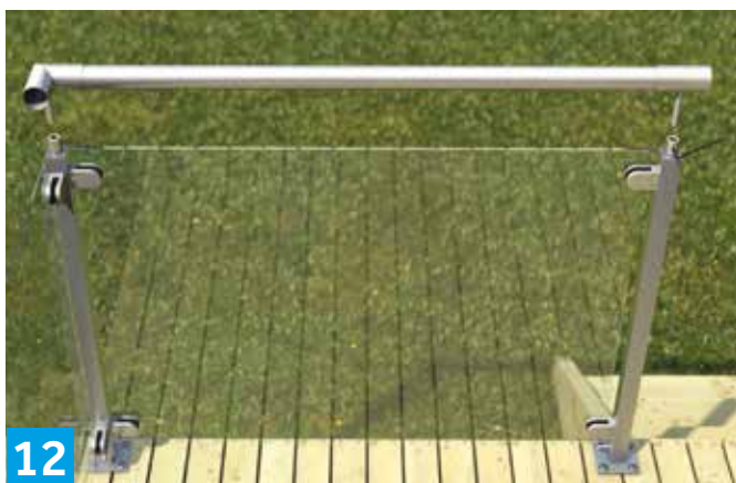
Håndløperen tres pent inn i holderne, deretter plasseres holderne ned i toppen på rekkverksstolpene.
