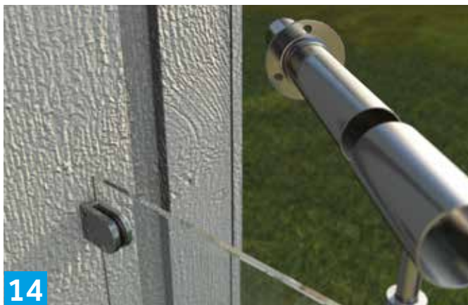
Håndløper i stål kappes og tres inn i holderen på midtstolpe og i veggfestet.
