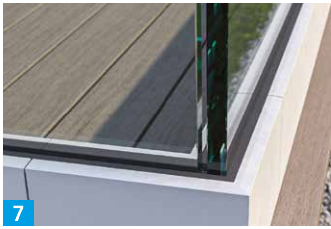
7 Det skal være min. 3 mm avstand mellom glassene. Hvilke glass som går ut eller imot, avgjøres av kalkulasjon/prosjektering.
