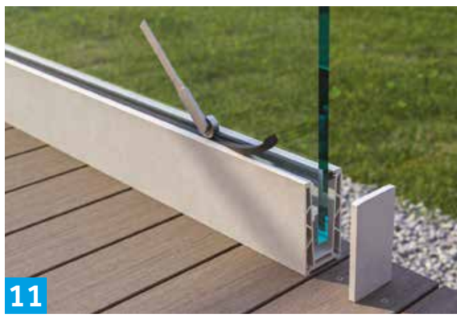
11 Gummipakningen monteres ved hjelp av rullehjulet på justeringsverktøyet. Montering av endeløkk gjøres enkelt med påmontert tape.
