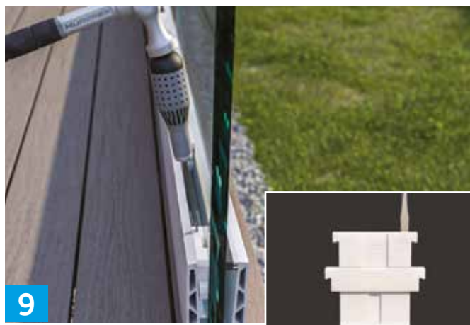
9 Glassene låses ved at øvre delen av låsekilen bankes forsiktig ned.
