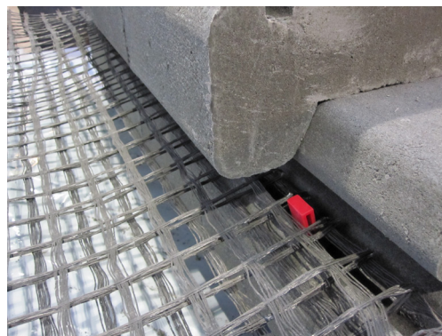
Bilde 3. Montering av Geonett.
