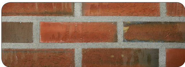
Ulefos Rustikk Bratsberg teglverk
