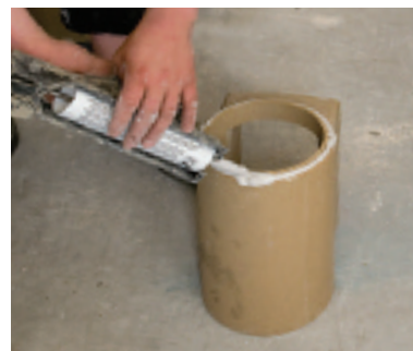
Sotluckerøret påføres fugekitt på nedre fals
