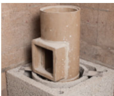
Sotluckerøret monteres på toppen av kondenspotten
