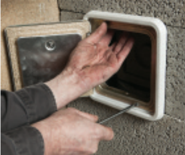
Sotluken skrues fast med medfølgende skruer og festebeslag
