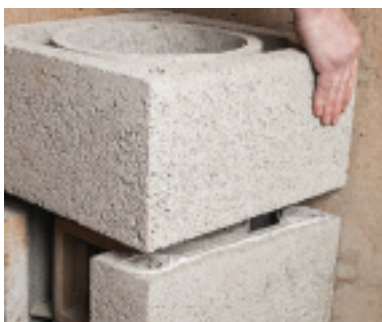
Ytterelement monteres og påføres fugekitt
