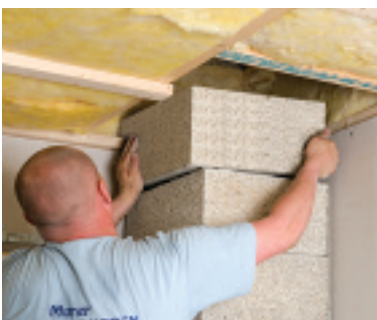
Element før bjelkelag monteres
