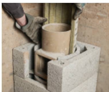
Isolasjonen tilpasses og monteres på bakre del av sotluckerøret for støtte
