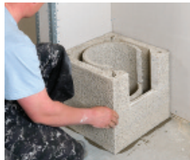
Sotlukeelementet limes fast på ytterelementet
