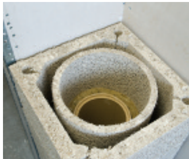
Ytterelement, isolasjon og foringsrør monteres
