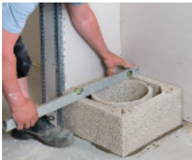
Ytterelementet limes fast på fundamentet og vattes opp. Alternativt kan et startelement med integrert tilluftadapter benyttes
