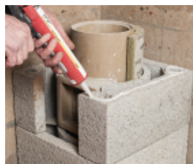
Fugekitt påføres sotlukeelementet
