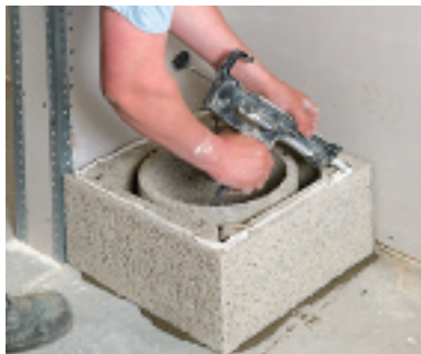
Fugekitt eller lim påføres ytterelement
