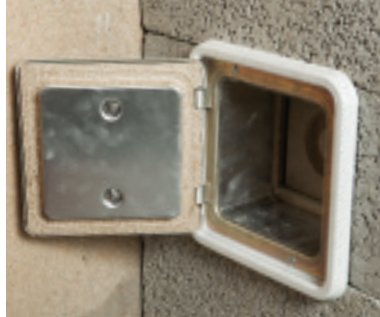
Pass på at den innvendige rammen på sotluken skyves inn mot rammen på sotluketøret. Deretter monteres medfølgende dørstein
