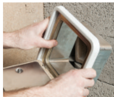
Innvendig teleskop ramme på sotluke justeres
