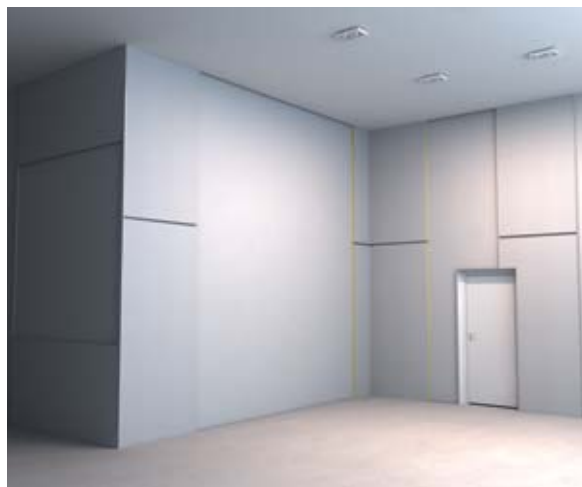
6.3 Ferdigmonterte ytterplater med vannrette hatteprofiler.
