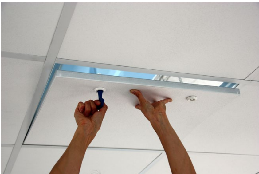
Samme overflate som på himlingen og enkel åpning av inspeksjonsluken.
