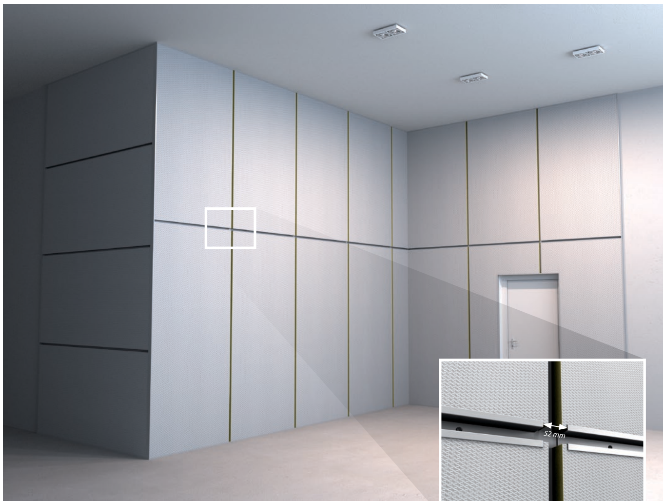
6.4 Monter de resterende plater og vannrette hatteprofiler, idet det arbeides inn mot midten.
