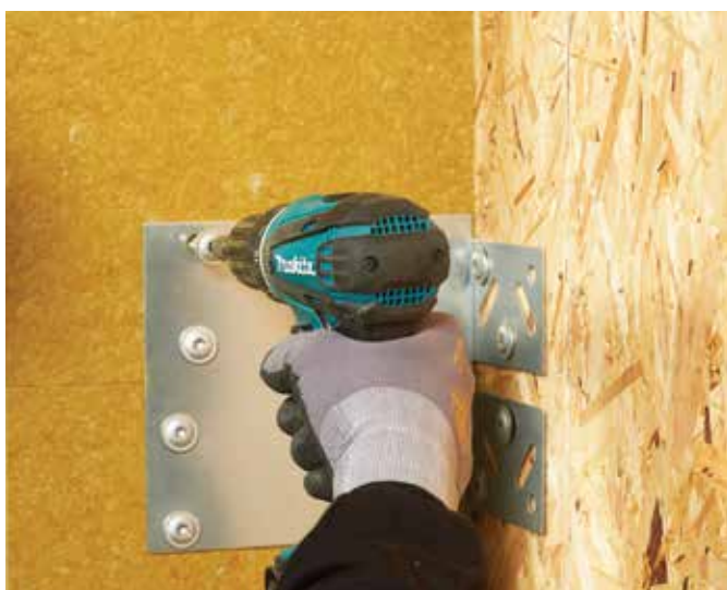
Skjøtebeslag ved skjøting.
