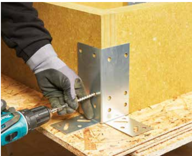
Montering skjer med hjørnebeslag og medfølgende skruer.
