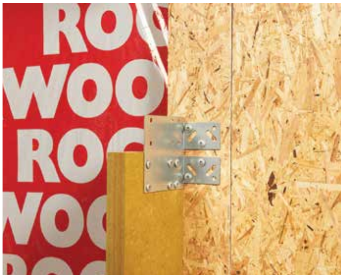
REDAir LINK skjøtebeslag monteres på veggen.
