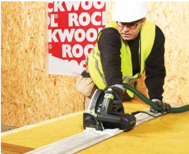
REDAir LINK plate kan skjæres til med vanlig verktøy.
