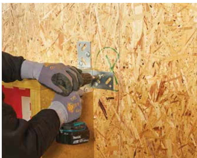
REDAir LINK monteres på veggen med egnet skrue.
