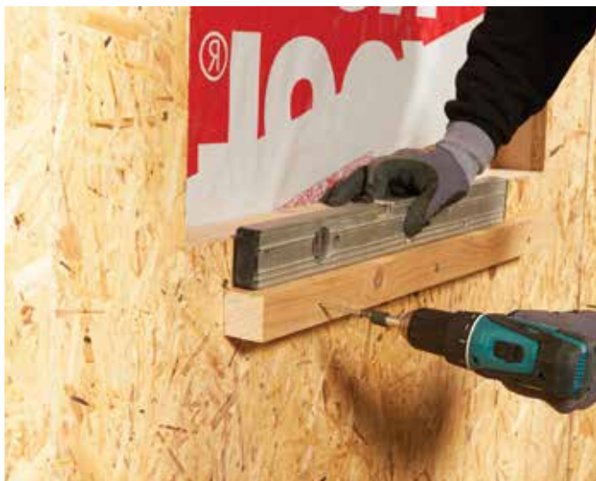
Eksempel på midlertidig lekt for å støtte REDAir LINK ved montering.
