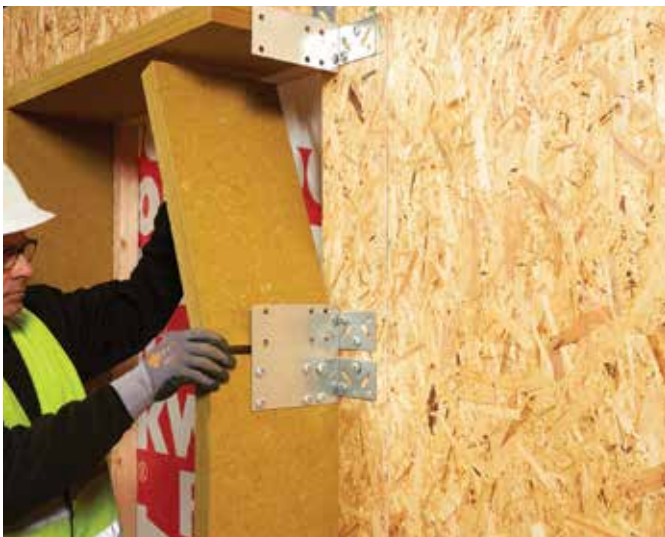
Skjøtebeslaget benyttes ved skjøting.
