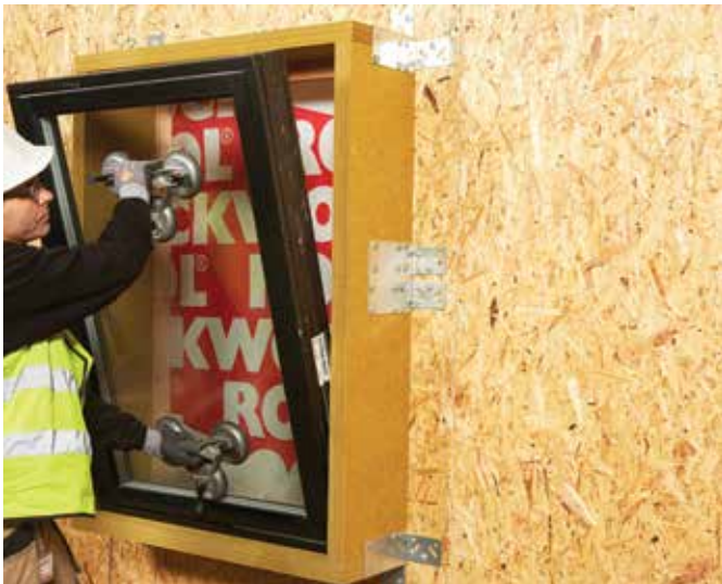
Vinduet løftes på plass.
