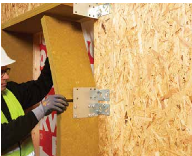
REDAir LINK platen festes i de forhåndsmonterte beslagene.
