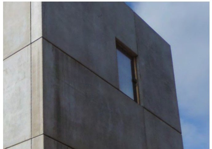
Eksempel på vegg i toleranseklasse I
