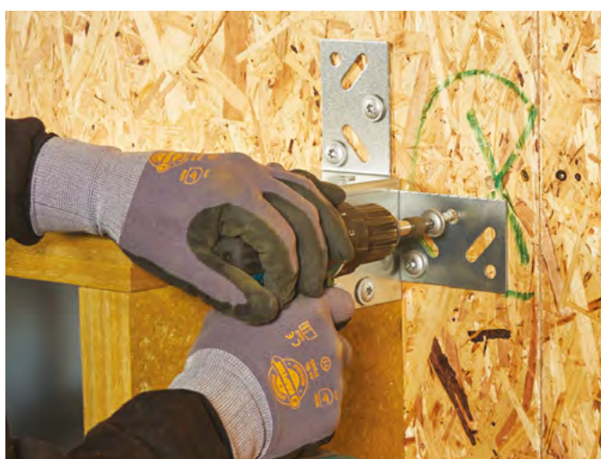
REDAir LINK monteres på bakveggen med egnet skrue
