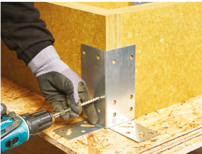
Montering av lang monteringssskrue ved hjørnebeslag
