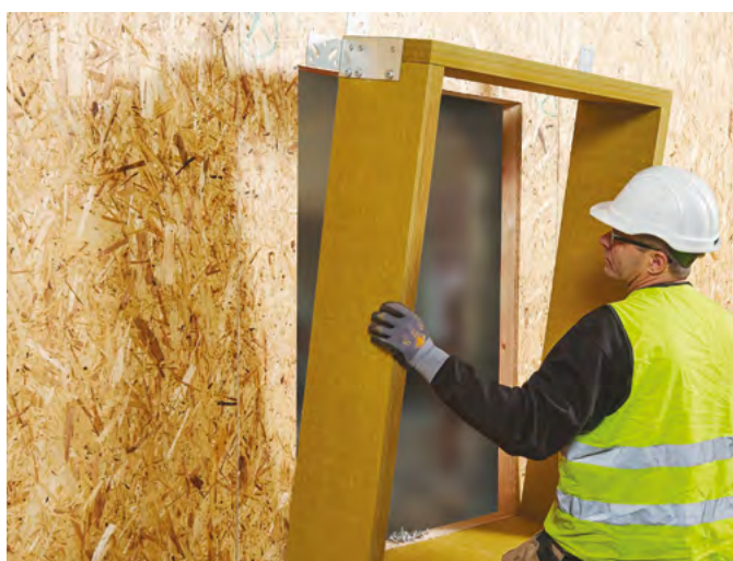
REDAir LINK løftes på plass.
