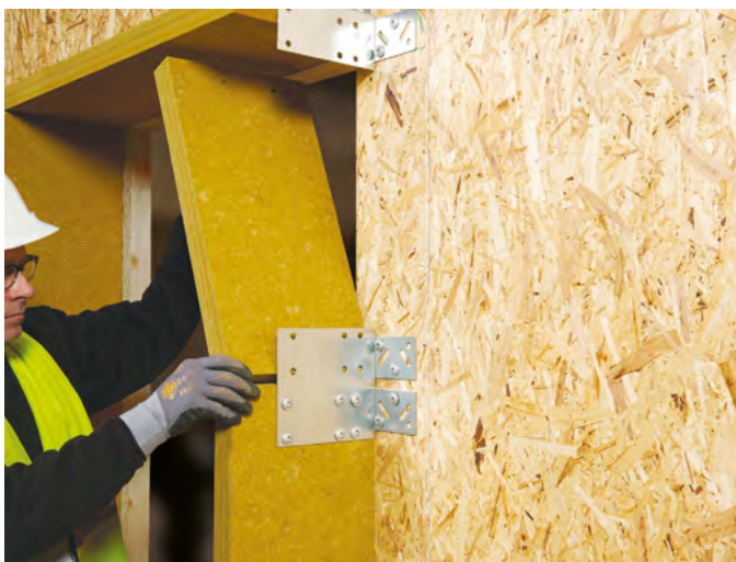
REDAir LINK Platen festes i de forhåndsmonterte beslagene
