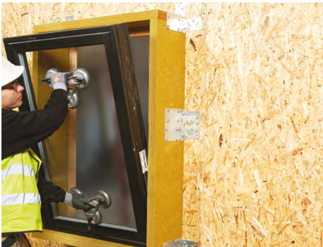
Vinduet løftes på plass i REDAir LINK.
