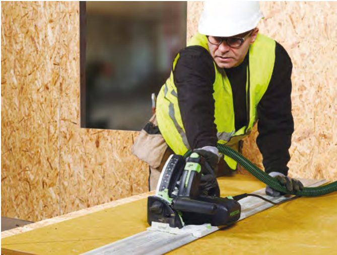
Tilskjæring av REDAir LINK Plate med alminnelig håndverktøy
