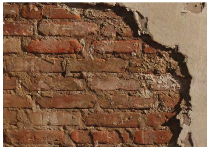
Eksempel på vegg i toleranseklasse III
