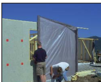
10 Rull ut Rockwool Vindsperre og stift fast i bunn og topp.
