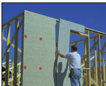
7 Skjær til platene og trykk på plass rundt vinduer og dører.
