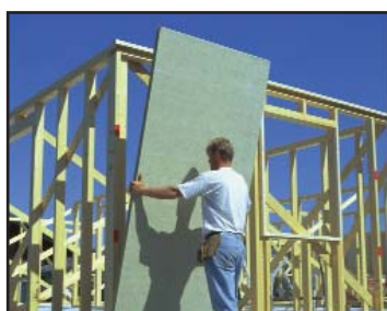
6 Platen settes mellom lektene og skyves inn på avstandsholderne.
