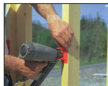
5 Avstandsholderen kan evt. stiftes fast til stenderne med kramper.
