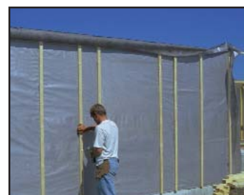
11 Lekter monteres ved hjelp av lekteskruen gjennom avstandsholderen.
