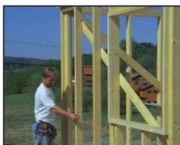
3 Merk av i to høyder hvor avstandsholderne skal plasseres.
