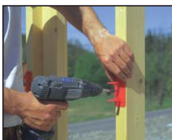
4 Avstandsholderne skrues fast med medfølgende monteringskruer.
