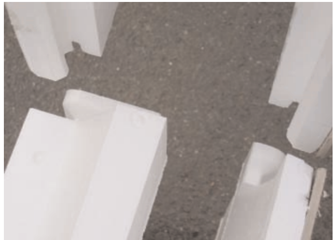
Montering av rette element.
