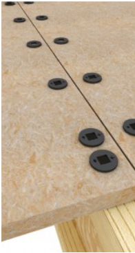
Montering af gulvplader på træstrøer
