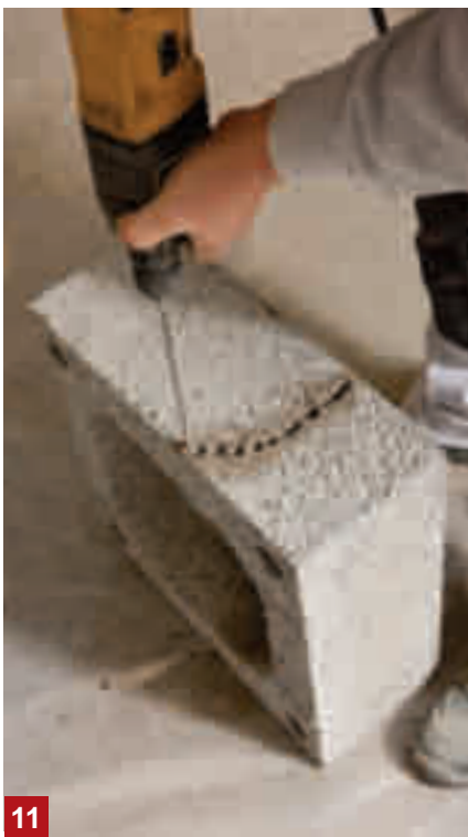
11. Det bores tett med hull langs merkingen og bitene fjernes fra ytterelement(ene).
