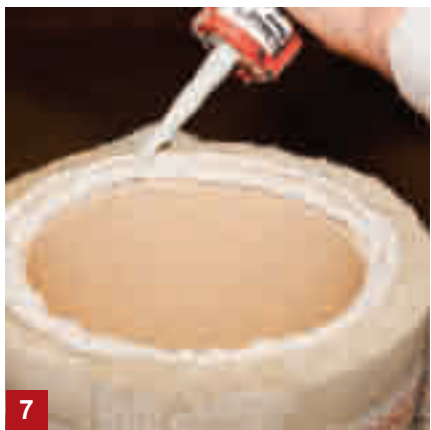
7. Husk rikelig med ildfast masse mellom hvert innerrør.
