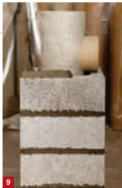
9. Montér pipe komplett opp til ca. 30 cm under ønsket høyde for senter røykuttak. Tørrmonter røykrøret med røykinnføringen for å se om avstand fra gulv blir som ønsket. Mål avstand fra topp ferdig montert ytterelement til underkant røykinnføring.
