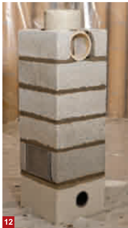
12. Montér så ytterelement (ene) med utsparingen. Klaringen mellom røykinnføring og ytterelementet skal være 1,5 – 2,0 cm hele veien rundt.
