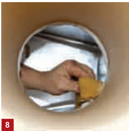
8. Masse som presses innover mot innerrøret glattes på innsiden. Bruk minst 1 stk patron pr. ca. 2,5 lm innerrør.
