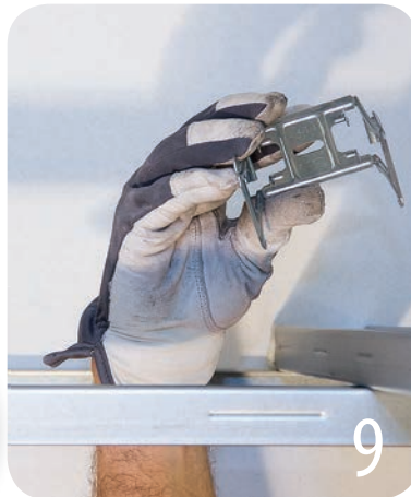
Sett sammen primær- og sekundærprofil med kryssbeslag.
