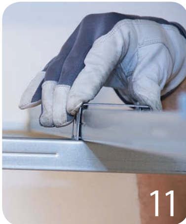
Klem sammen kryssbeslagets fliker for å låse profilens plassering. Dette kan åpnes og etterjusteres ved behov.
