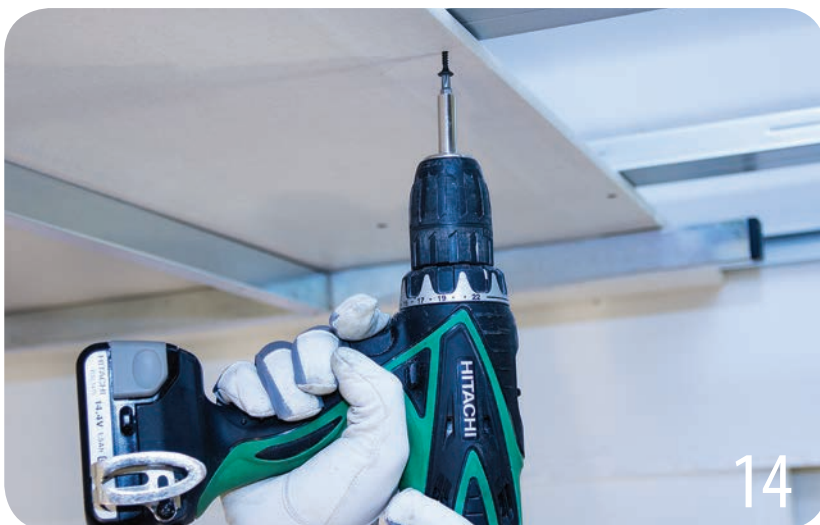
Norgips Plan monteres på tvers av profilene og skrues mot underlaget med ca 20 cm skru-avstand langs platekantene og inne på platen. I en flerlagskonstruksjon er det viktig at plateskjøtene forskyves mellom platelagene.
