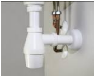
Synlig del av 32 mm rørsystem før oppussing.
