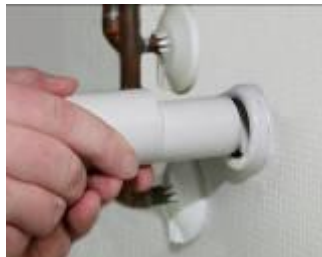
Eksentrisk, traktformet reduksjon fra 40 mm til 32 mm plasseres lett tilgjengelig.
