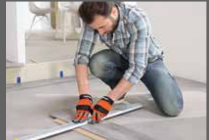
Underlaget skal være rent, plant og tørt
