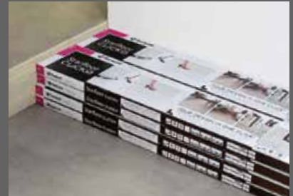
La pakkene ligge plant i rommet før legging
