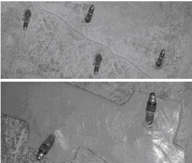
Figur 1 og 2. Injektionsnpler, placeret omkring revnen og forsejlet med den korrekte epoxyklæber.
