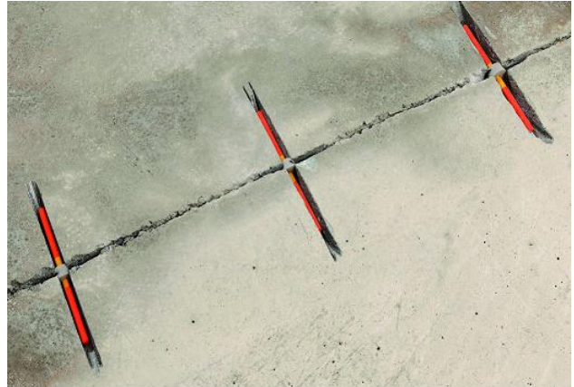
Figur 4. Placering af ankre i de riller, der er lavet i revnerne.
