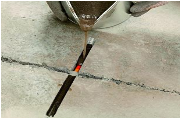
Figur 7. Fyldning af ankerrillerne med MasterInject 1360-blanding.
