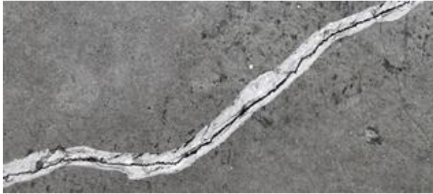
Figur 3. Revneåbningen skåret op i V-formet rille.
