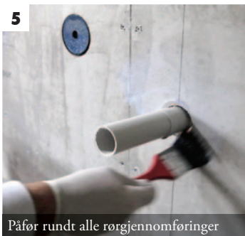
Husk å prime alle flater som skal flislegges
