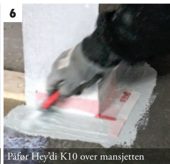
Hjørnet strykes inn i membranen
