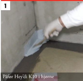
Hjørnet strykes inn i membranen
