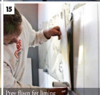
Prøv flisen for liming
