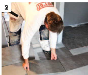
Prøvelegg flisene før liming
