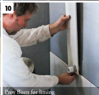
Prøv flisen for liming
