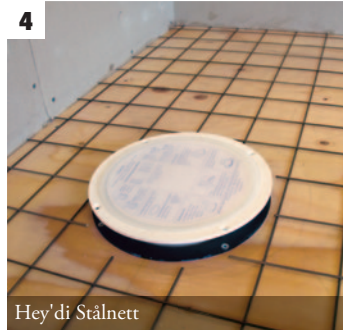
Kramp fast stålnettet til underlaget
