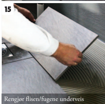
Lim sluket i plan med flisen
