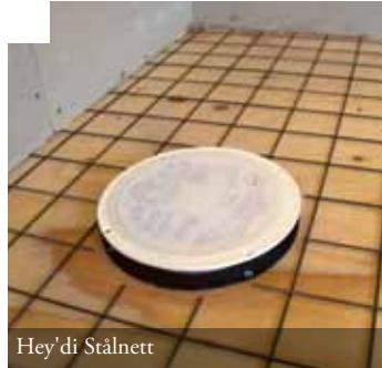
3 Kramp fast stålnett til underlaget
