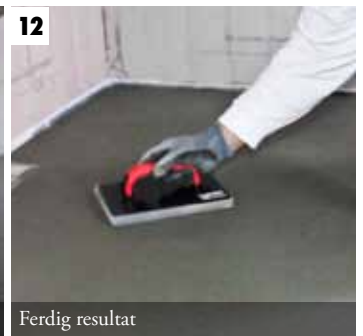
8 Komprimer støpemassen
