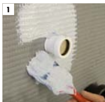
1 Hey'di K10 påføres underlaget i et jevnt og fyldig strøk.
