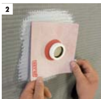
2 Hey'di Rørmansjett dras over røret og trykkes godt inn i membranen.
