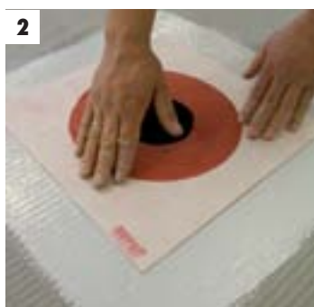
2 Hey'di slukmansjett monteres over sluket og klemmes fast slik at man får en god limeeffekt.
