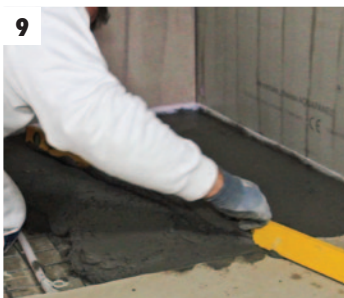
9 Kontroller fallet med vater
