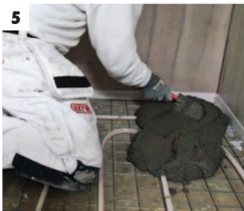
5 Jobb massen ut med en mureskje
