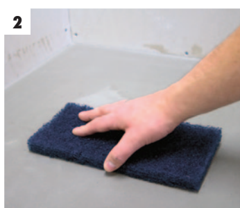
2 Slip underlaget lett mekanisk
