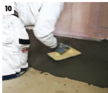
10 Overflaten glattes med murebrett
