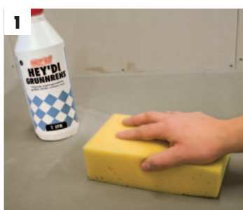
1 Rengjør overflaten
