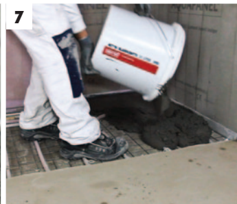
7 Påfør mer støpemasse
