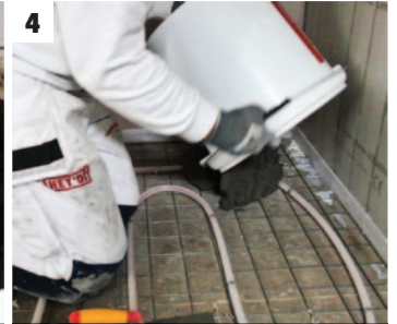
4 Tøm støpemassen på gulvet
