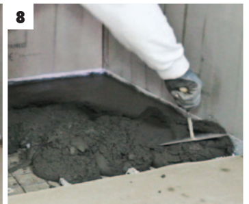
8 Komprimer støpemassen
