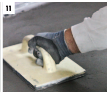
11 Overflaten skal være grov
