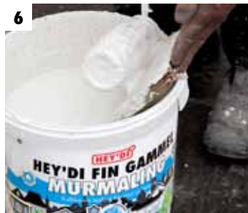
6 Påfør godt med maling på rullen
