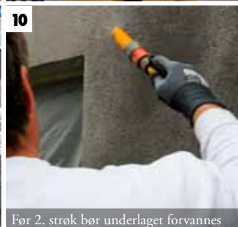
Før 2. strøk bør underlaget forvannes
