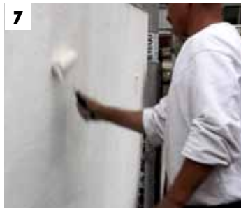
7 Fortsett til hele veggen er ferdig
