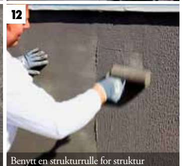
Benytt en strukturrulle for struktur
