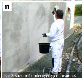
11 For 2. strøk må underlaget igjen forvannes
