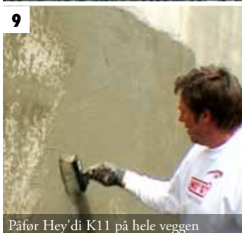
9 Påfør Hey'di K11 på hele veggen
