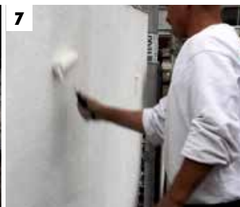
7 Fortsett til hele veggen er ferdig
