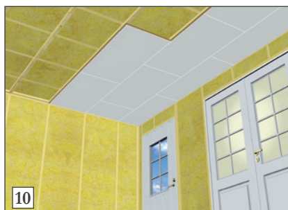
10) Resten av plateradene monteres på samme måte, og taket er ferdig.
