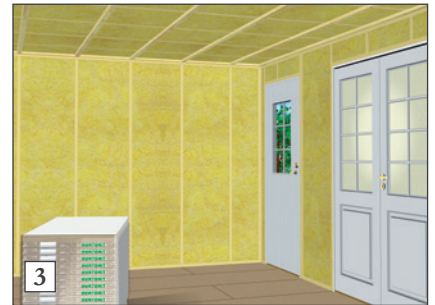
3) Montering skjer vanligvis på langsgående elektrikerlekker med avstand c/c 60 cm. Alle frie platekanter skal understøttes. Ved montering av smalere takplater, må lekkeavstanden justeres slik at de passer til bredden av takplatene.
