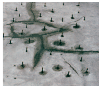
Støp revner og komprimer hulliggende underlag med PCI Apogel F.
