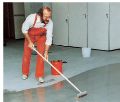
PCI Epoxigrund 390 arbeides inn i det forberedte underlaget med en bred pensel.
