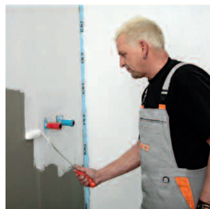
PCI Lastogum påføres underlaget uforynnnet med rulle, kost eller sparkel.
