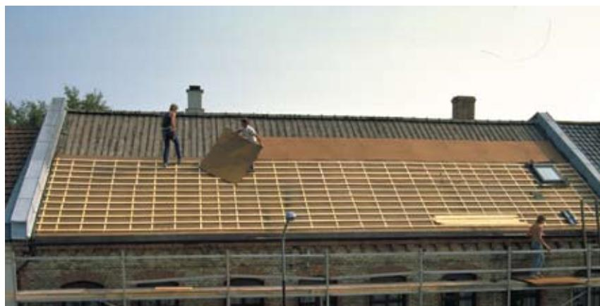
På gamle tak av bord, lagt som over- og underligger, skal sutakplatene legges i forband med omlegg som ellers. Sutakplatene er sterke og hendige å arbeide med på taket.
