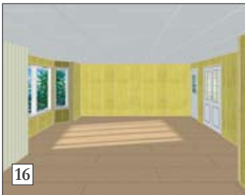
16) Resten av platene monteres på samme måten.
