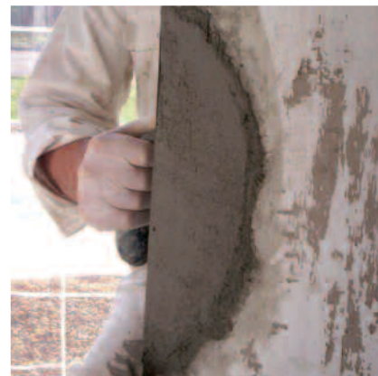
Reparasjon av hjørner og kanter – kun én av mange bruksmuligheter for den universelle reparasjonsmørtelen PCI Nanocret R2
